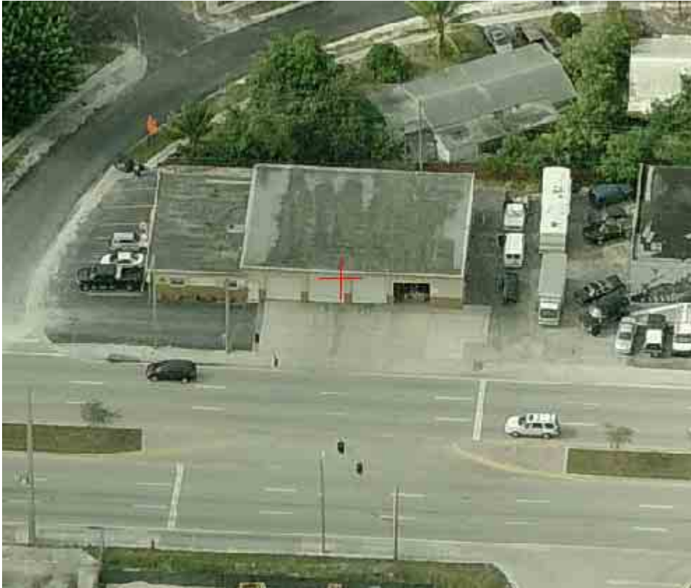
FIRE STATION #20 4721 NW 9TH AV
