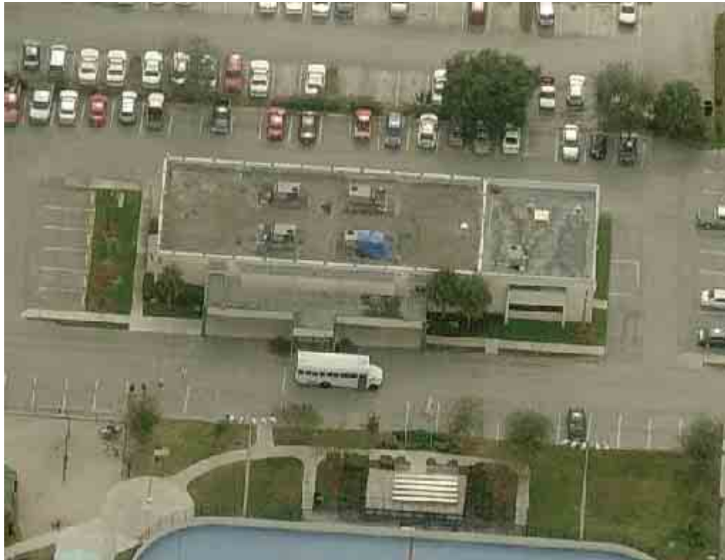
COLLINS RECREATION CENTER 3900 NE 3RD AV
